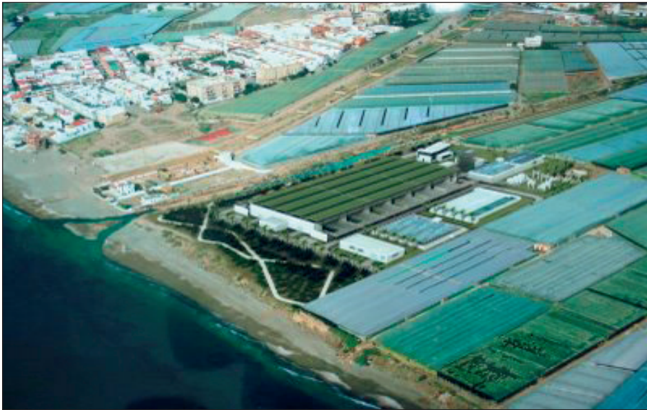
Fotografía 9. Desaladora. Campo de Dalías. (Almería).
